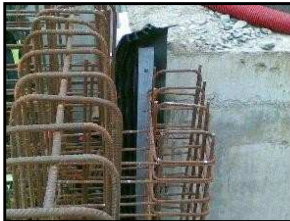
Těsnící PVC-P pás mezi starým a novým betonem v praxi
