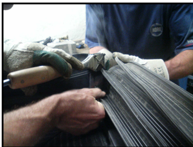
Ruční svařování PVC-P těsnících pásů sekyrkou
