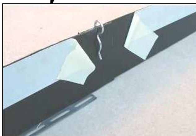
2 Spojení plechu prepiatovat minimálne 5 cm a zajistit sponkou
